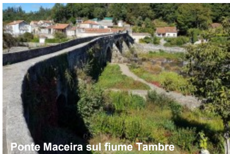
Ponte Maceira sul fiume Tambre
